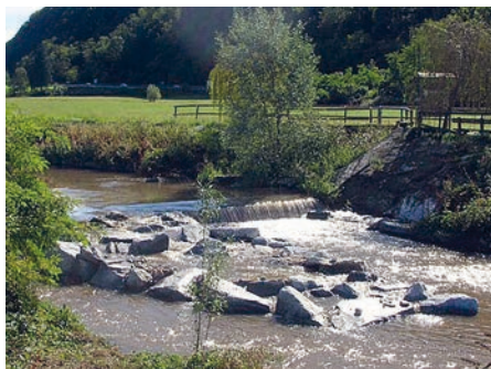
Esempio di rampa artificiale realizzata sul Torrente Margorabbia (VA)
