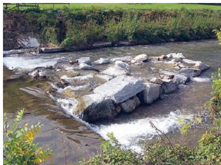
Esempio di rampa artificiale realizzata sul Torrente Margorabbia (VA)
