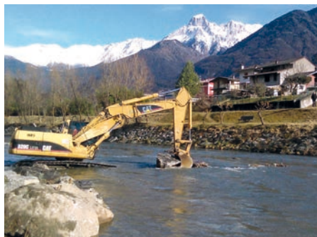
Fase di posizionamento dei massi in alveo
