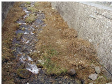
La bonifica totale della vegetazione ripariale espone il collettore al rischio di ricolonizzazione massiva di vegetazione esotica
